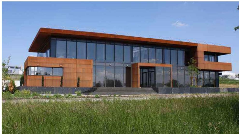
Die Konstruktion der Fassade ist eine Pfosten-Riegel-Konstruktion aus Holz. Mit der auf der Außenseite der Fassadenverglasung in Sicherheitsglas-Ausführung aufgetragenen Sunexx®-Klebefiltermembrane wird Nanometergenau ungewollte Wellenlängen des Sonnenlichtes abgefiltert und die Wärmestrahlen durch Reflexion reduziert.
